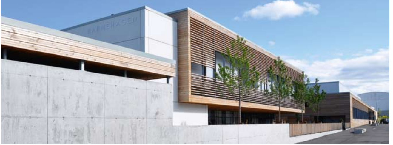
Barnehagen sett fra syd. I alle bygg spilles det på en kombinasjon av tre og betong (hvite elementer og grå støpt betong) som kontrast mellom varmt og kaldt, mykt og hardt, lyst og mørkt. Materialvalget reflekterer volumenes komposisjon – store forankrete volumer i betong med lette, 'svevende' bokser i tre – oppløst foran vinduene til trespiler. Foto KB
