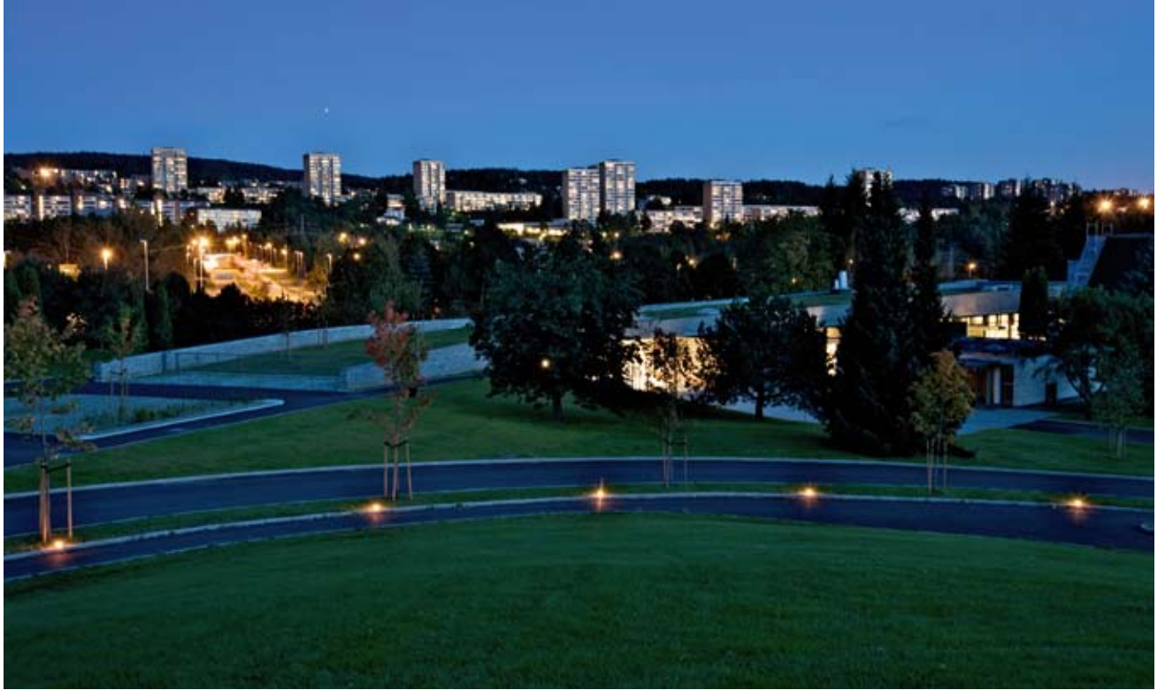
Krematoriet skyter ut av terrenget som en beskyttende mur mot trafikken utenfor
