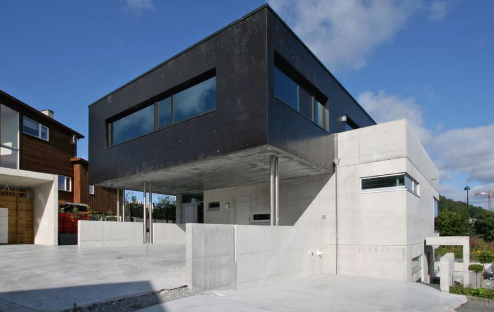
Sett fra øst. Inngangsparti med dekke i betong, samt overdekket inngang til underetasje i betong
