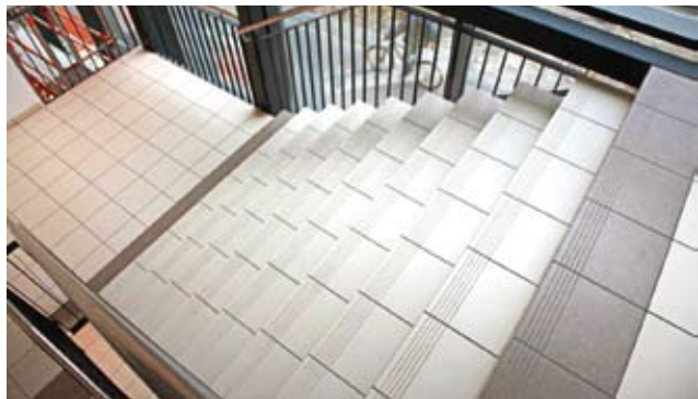
Trappen på bildet over har godt synlig markering på hvert trinn. Trappen på bildet under har kontrastmarkering på øverste og nederste trinn samt markering på hvert trinn i form av riller. Begge eksemplene innfrir forskriftskravene, men eksemplet over har tydeligst trappkantmarkering.
