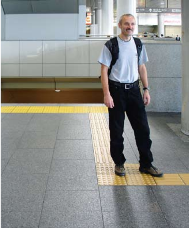
Eksempel på faremarkering ved trappen. Kanten på trappen har runde knaster mens selve ledelinjen har riller
