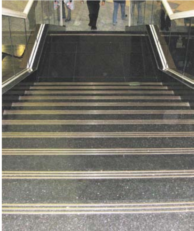
Trappen på bildet over har godt synlig markering på hvert trinn. Trappen på bildet under har kontrastmarkering på øverste og nederste trinn samt markering på hvert trinn i form av riller. Begge eksemplene innfrir forskriftskravene, men eksemplet over har tydeligst trappkantmarkering.
