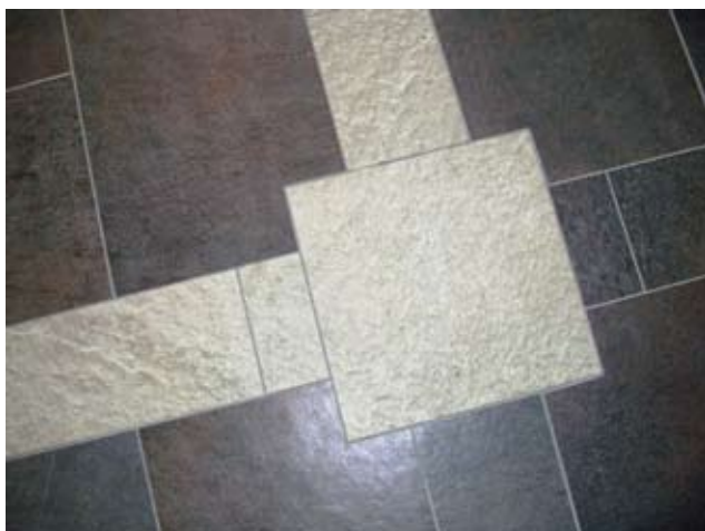
Oppmerksomhetsfelt: En større flis i gangkrysset signaliserer retningsendring
