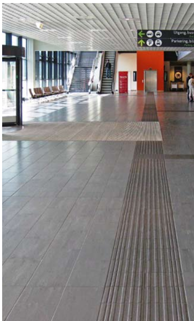
Et 800 mm bredt ledefelt på et flyplass markerer veien til utgang, heis og informasjon. I feltet skal det ikke plasseres gjenstander som kan komme i veien for blinde og svaksynte.
