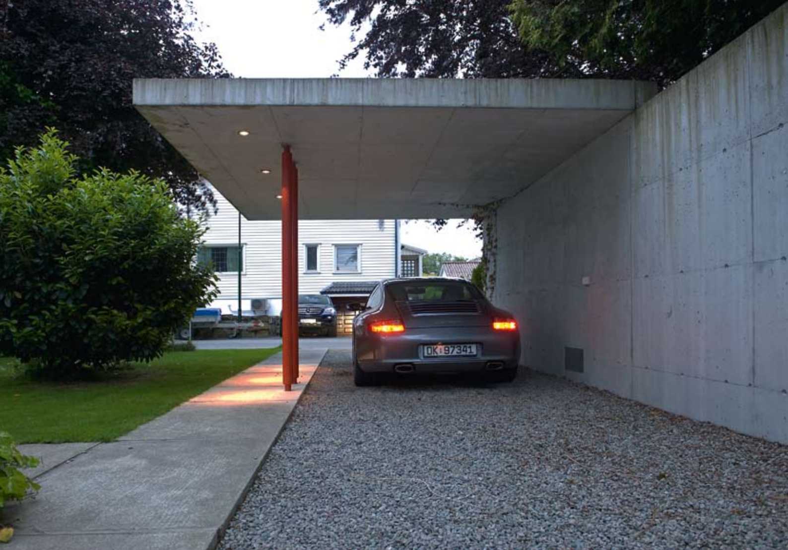
Mot øst. En plaststøpte betongskive i eiendomsgrensen med et tilsluttende betongtak over, båret av to røde stålsøyler
