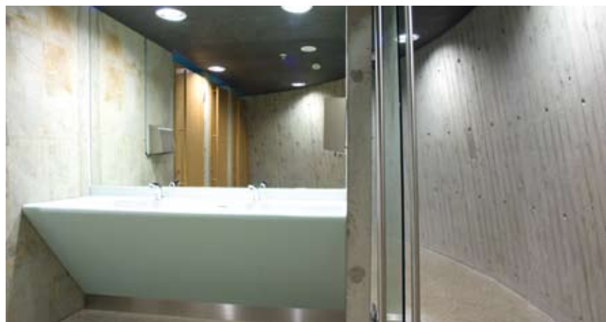
Plasstøpt betong med bordforskalling
