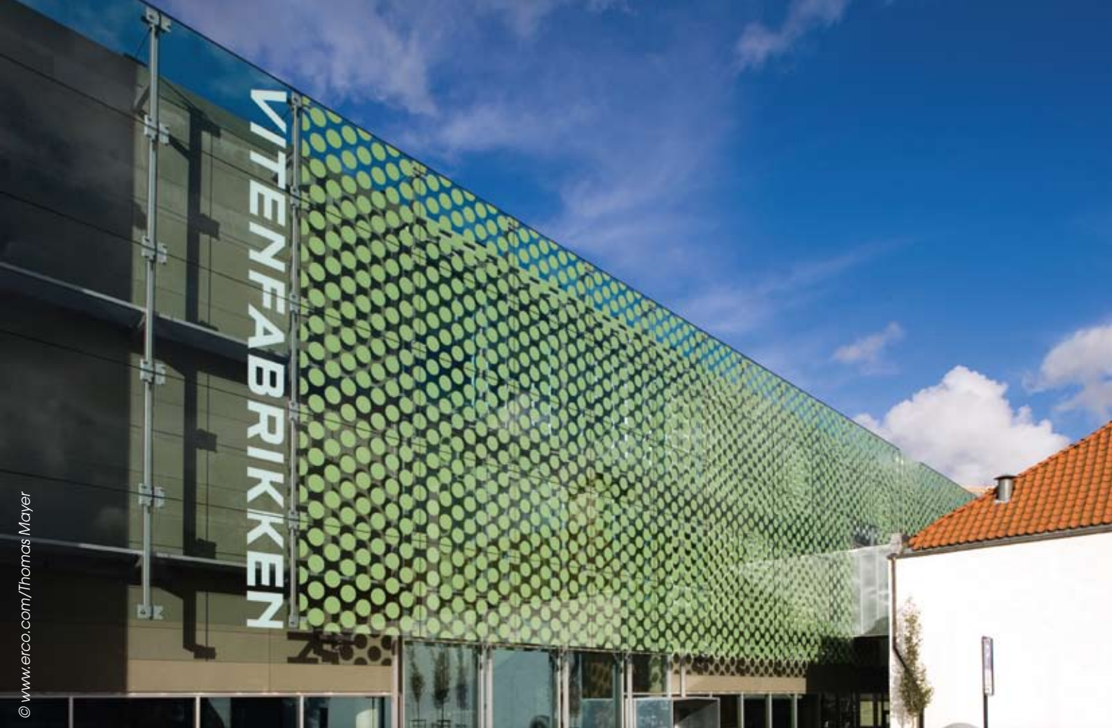
Fasaden over 1. etasje har utvendig kledning av glass i et sjikt utenfor selve ytterveggen. Glasset har silkestrykket mønster med belysning bak
