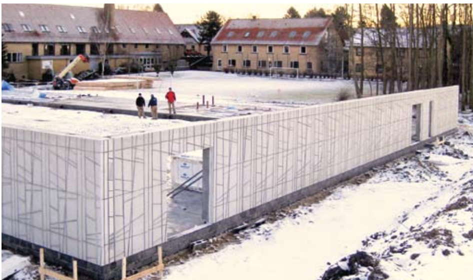
Kerteminde Efterskole, Arkitektfirmaet TKT A/S. Elementer fra Confac A/S. Det er valgt et enkelt, repeterende motiv med skrå og lodrette linjer. De lodrette linjene tar opp de upopulære elementskjøtene ca. hver sjette meter, slik at disse inngår diskret i mønsteret. Bemerk millimeterpresisjonen i utførelsen - de frilagte stripene er kun 20 mm brede.
