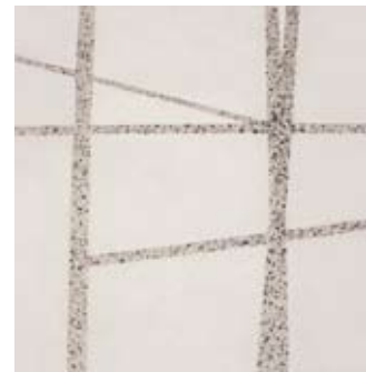
Kerteminde Efterskole, Arkitektfirmaet TKT A/S. Elementer fra Confac A/S. Det er valgt et enkelt, repeterende motiv med skrå og lodrette linjer. De lodrette linjene tar opp de upopulære elementskjøtene ca. hver sjette meter, slik at disse inngår diskret i mønsteret. Bemerk millimeterpresisjonen i utførelsen - de frilagte stripene er kun 20 mm brede.
