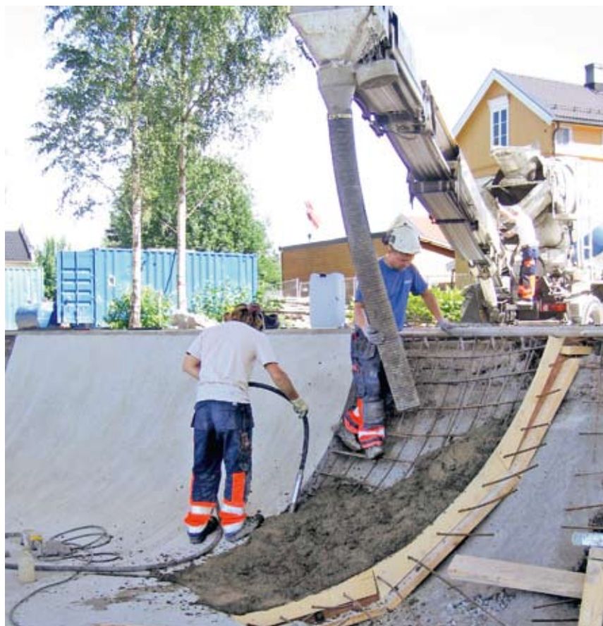
Utlagging av betong i krum flate i bowlanlegget
