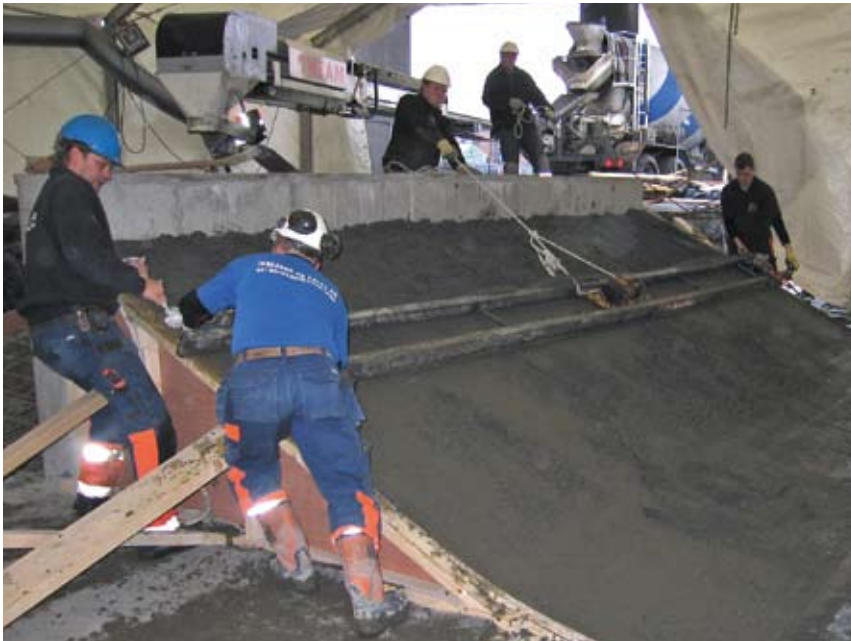
Avretting med vibrobrygge i skrå flate i streetanlegget
