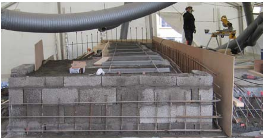
Lecablokker benyttet til bakforskaling
