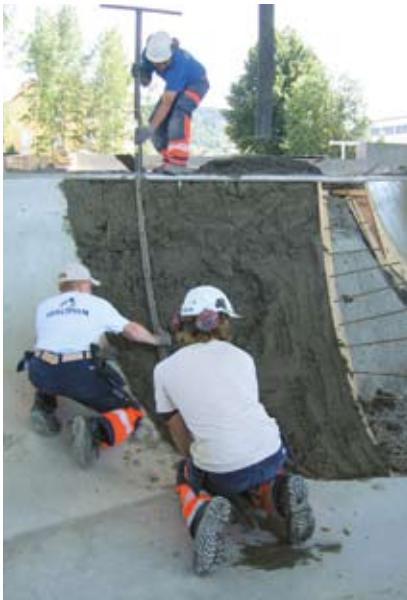
Avretting med 'bueholt' og etterfølgende stålglatting av dobbelkrum flate i bowlanlegget
