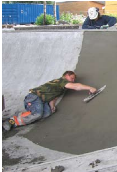
Avretting med 'bueholt' og etterfølgende stålglatting av dobbelkrum flate i bowlanlegget
