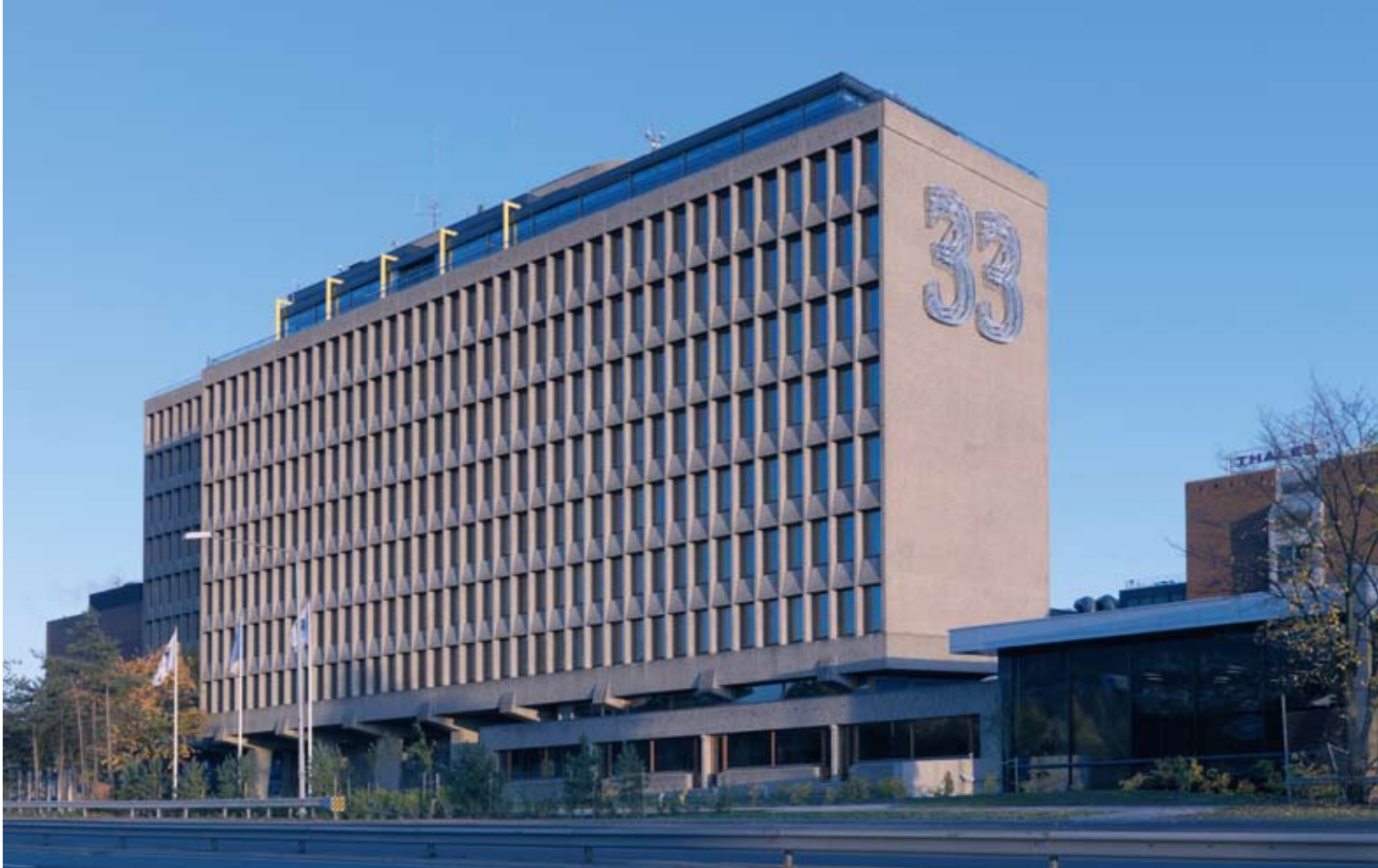
Sett fra Østre Aker vei
