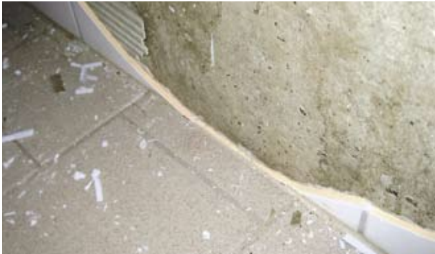
Bilde 6. Bildet viser et tilfelle med manglende mykfuge ved gulv. Veggflisen var satt helt ned på underlaget. Gulvflisen var limt inntil veggflisen og der var kun vanlig fugemasse mellom gulv og veggflis. Nederste flisrekke var løs.
