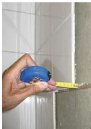
Bilde 2: Den ca 2,5 m høye flisflaten buler ut ca 10 mm på midten
