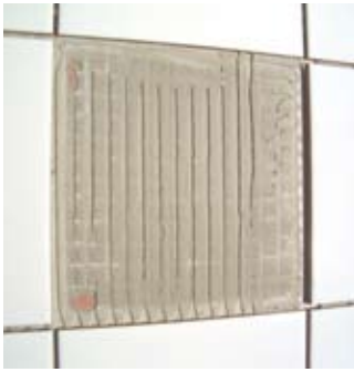
Bilde 5: Hvis flisen ikke trykkes godt inn i limet, vil vedheftsflaten og dermed også vedheftskapasiteten reduseres betydelig.
