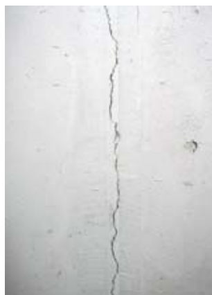
Bilde 4: Betongvegg med svinnriss fra bunn til topp. (Veggens bevegelsesmønster er illustrert i figur 1)
