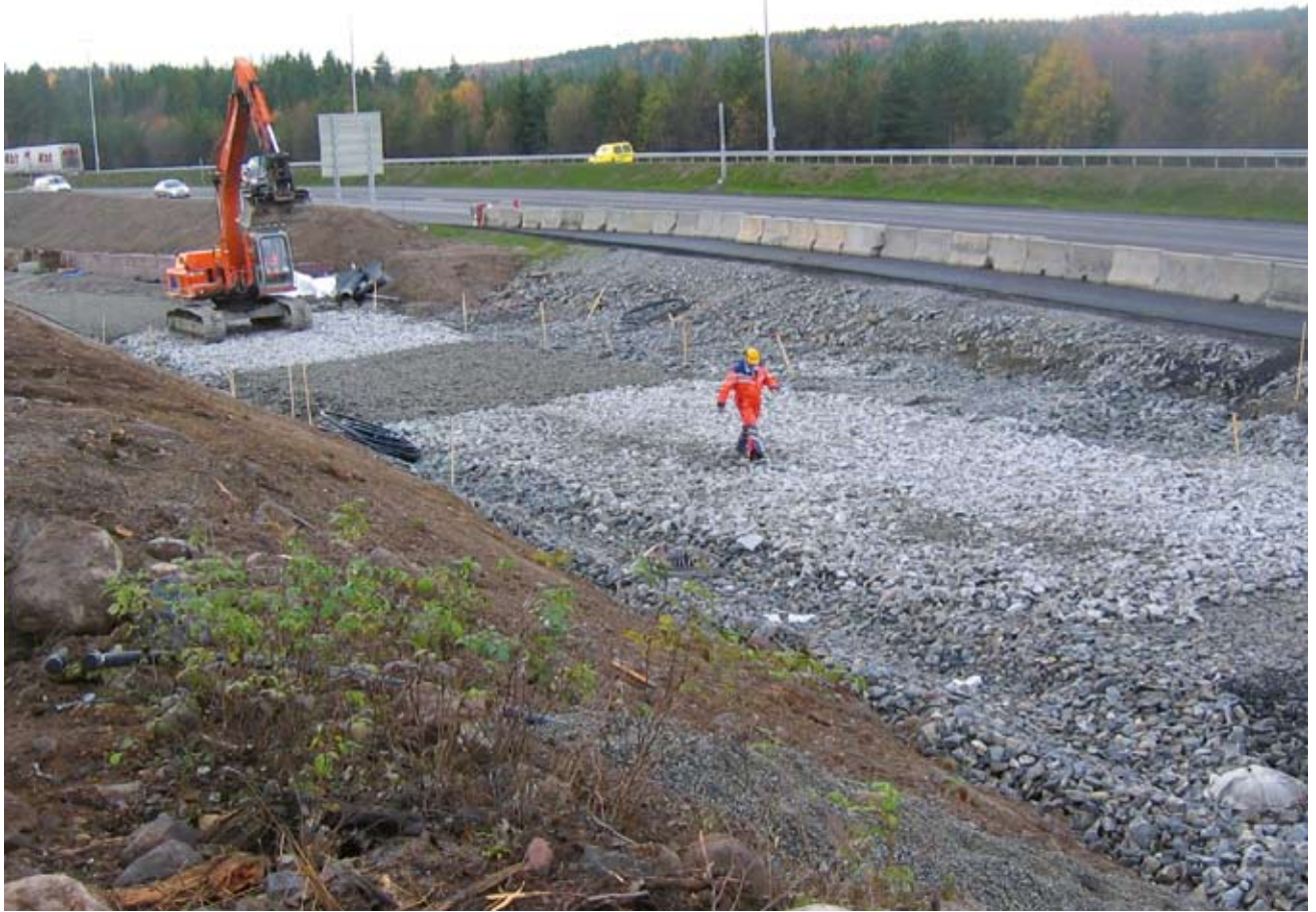
Bilde 3: Bruk av knust betong i forsterkningslaget i veg i forbindelse med utbyggingen av E6 syd (Assurtjern-Taraldrud-Oslo grense). Betongen er knust på stedet og hentet fra et gammelt veidekke av betong i umiddelbar nærhet. Foto: SINTEF Byggforsk
