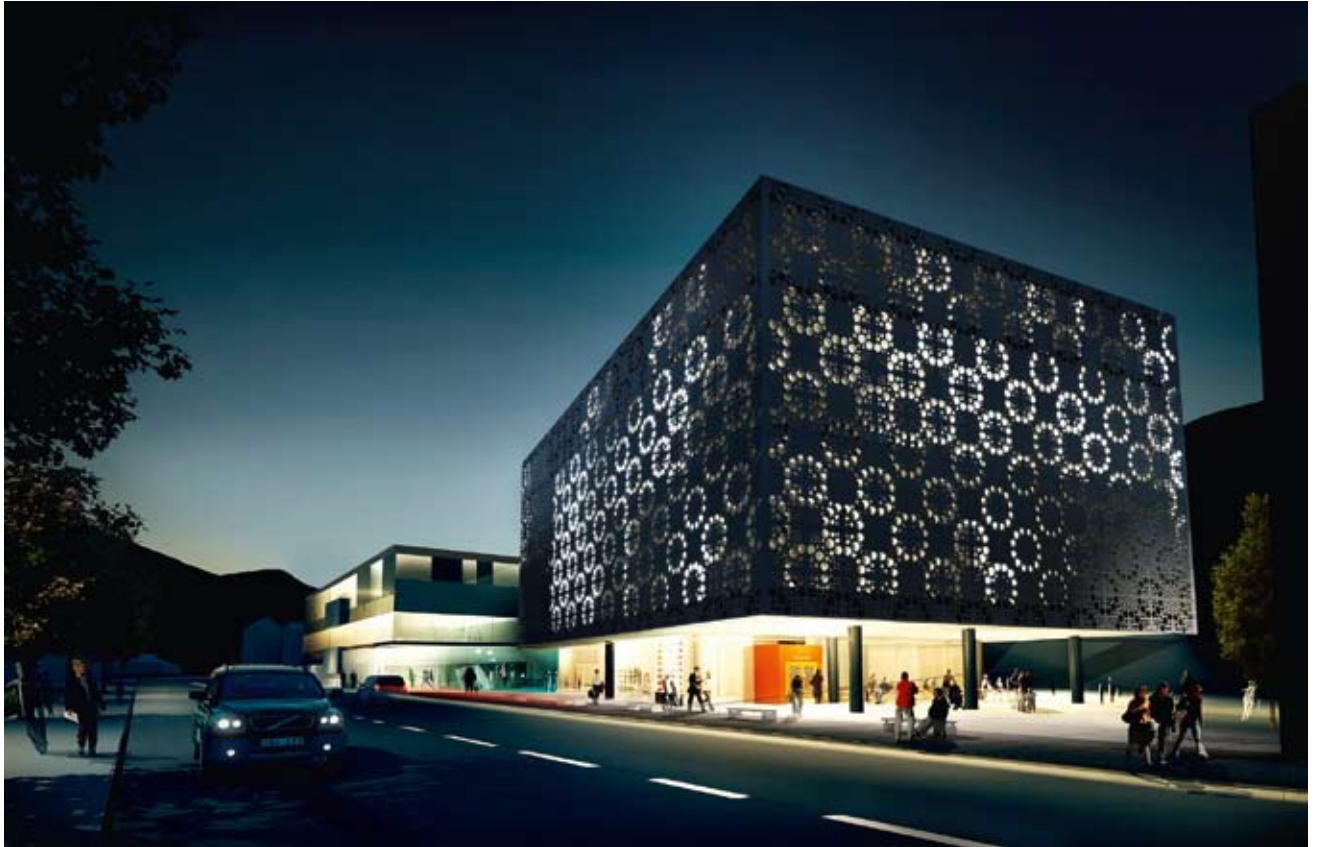
Transparent tegl 2, kvadrat av Hilde Angel Danielsen. Modell forslag fasade på kulturbygg
