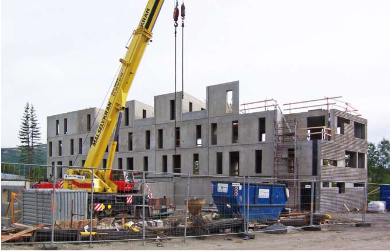
Montering av betongelementer
