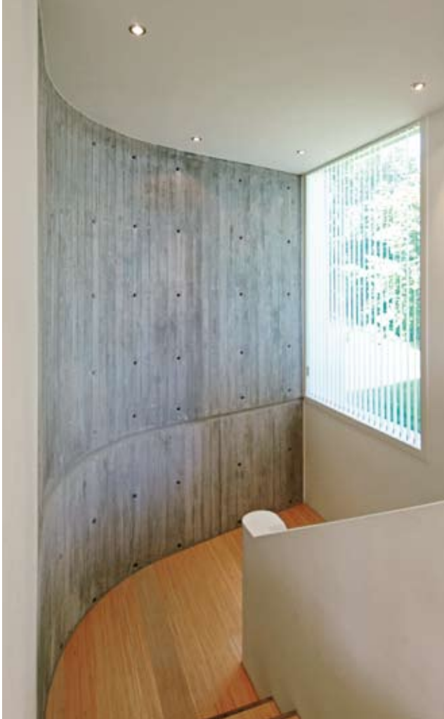
Plasstøpt trapperom med elementtrapp
