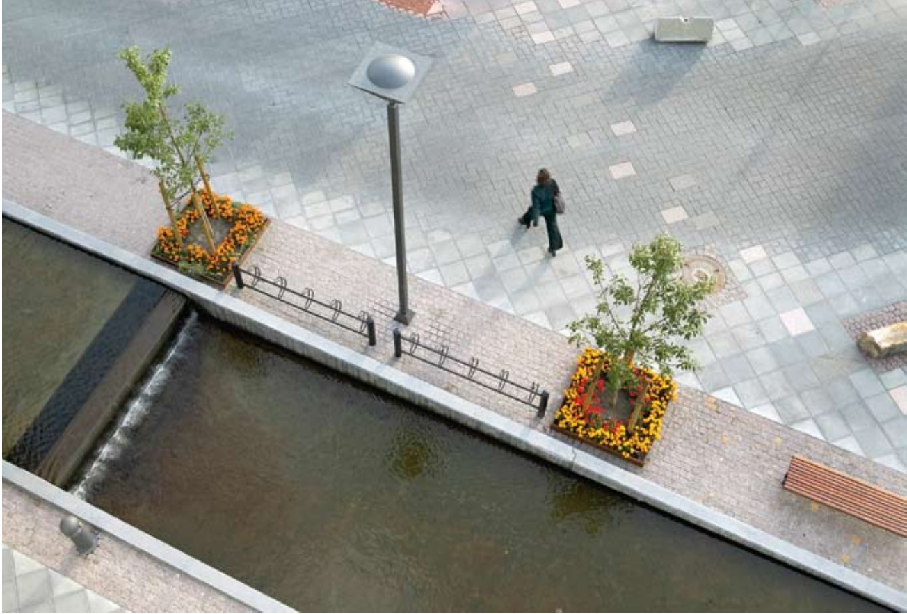
Kanalbasseng med terskel langs Ferjegata
