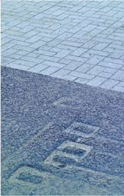
Skade på asfaltdekket etter container
