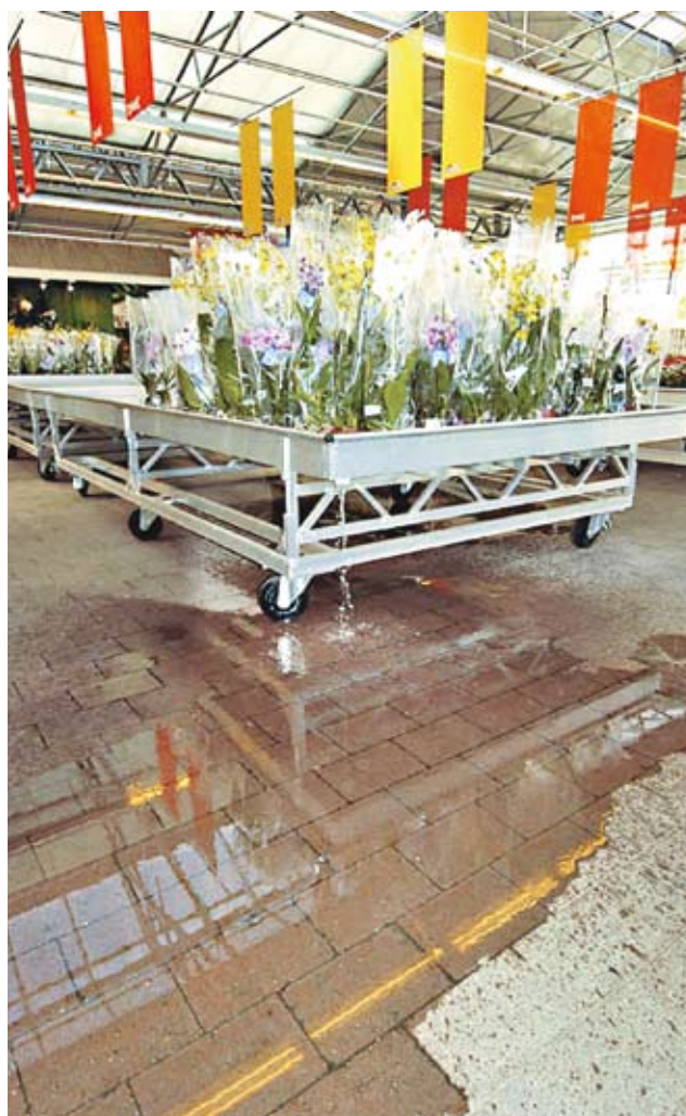
Gartnerier benytter ofte belegningsstein som dekke, bl.a. på grunn av den gode dreneringsevnen
