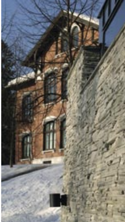
Kroppsøvingssalen er forblendet med tørrmur av skifer
