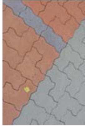
Dekke av belegningsstein uten fas gir lite støy
