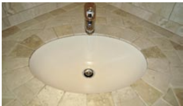
Flisene er limt med tokomponent polyuretanlim. Det er brukt fugeforsterker i fugemassen. Fugeforsterker gir bedre heft og mekanisk styrke og gjør fugene mer tette/vannbestandige
