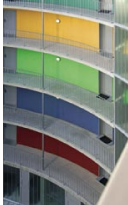
Fargesatte vegger mot svalgangene
