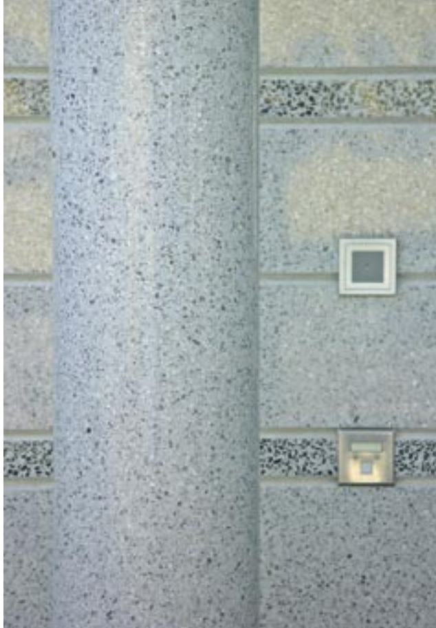
Boligbygg Helsingfors Vanlig grå sement med tilslag av mørk granitt i de smale feltene, blandet tilslag i de brede feltene og i søylen. Overflaten er slipt og polert.
