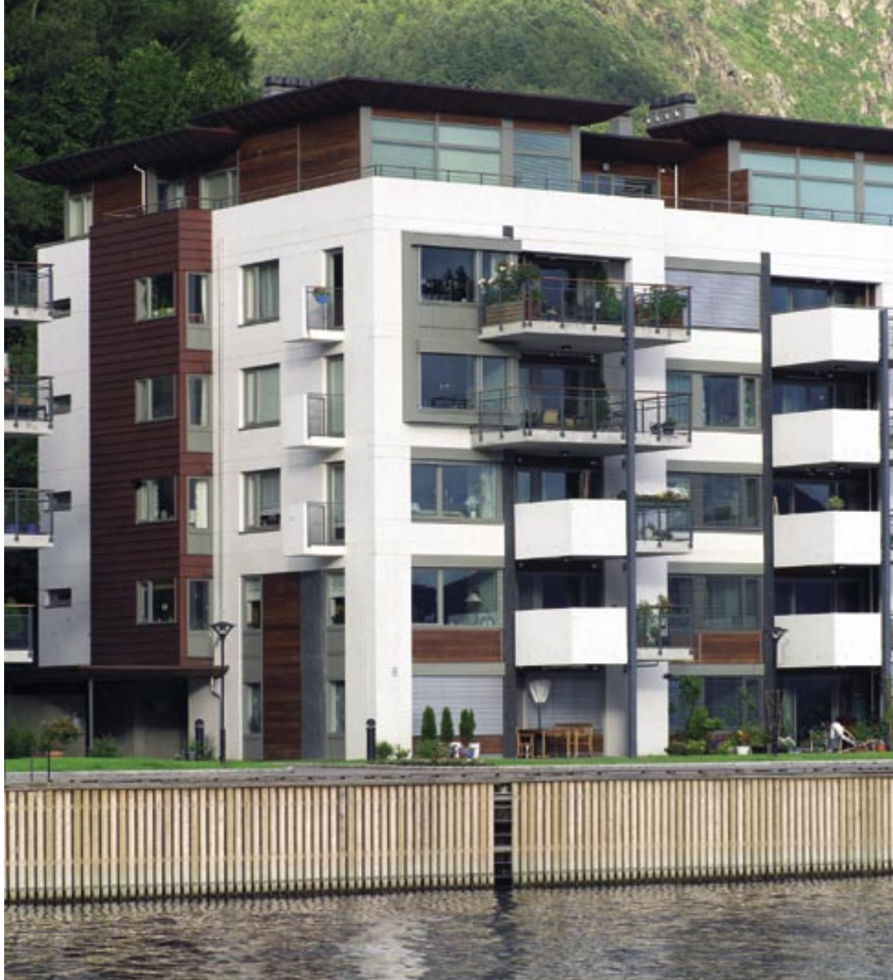
Jægers brygge. Arkitekt: Lund & Partner. Betongelementer: AS Betong. Boligprosjekt fra 2002. Betongelementer i bærende yttervegger, utvendige søyler, balkonger og balkongbrystninger. Fasadeelementene er mattslippte. De lyse elementene har tilslag av hvit marmorsingel i hvit sement. De mørke har tilslag av larvikitt i svart pigmentert betong.
