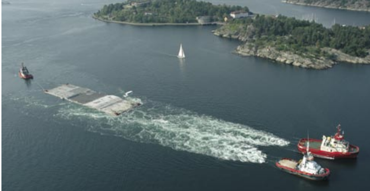
Under slep fra Hanøytangen til Bjørvika: Ett av seks SKB-elementer som skal benyttes i Norges første senketunnel
