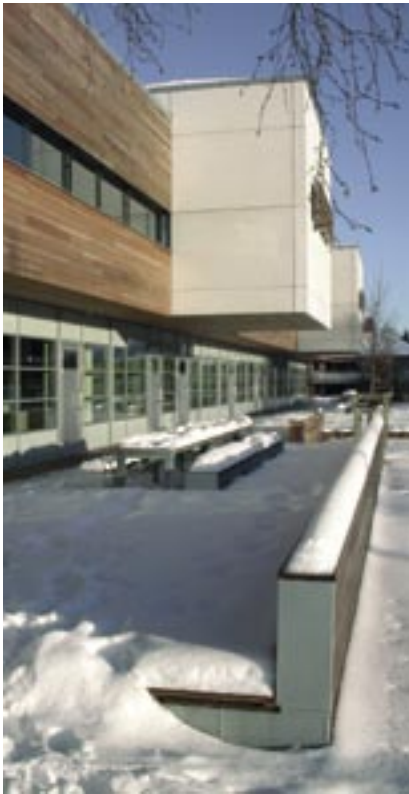
Fra terrasseanlegget i sørvest
