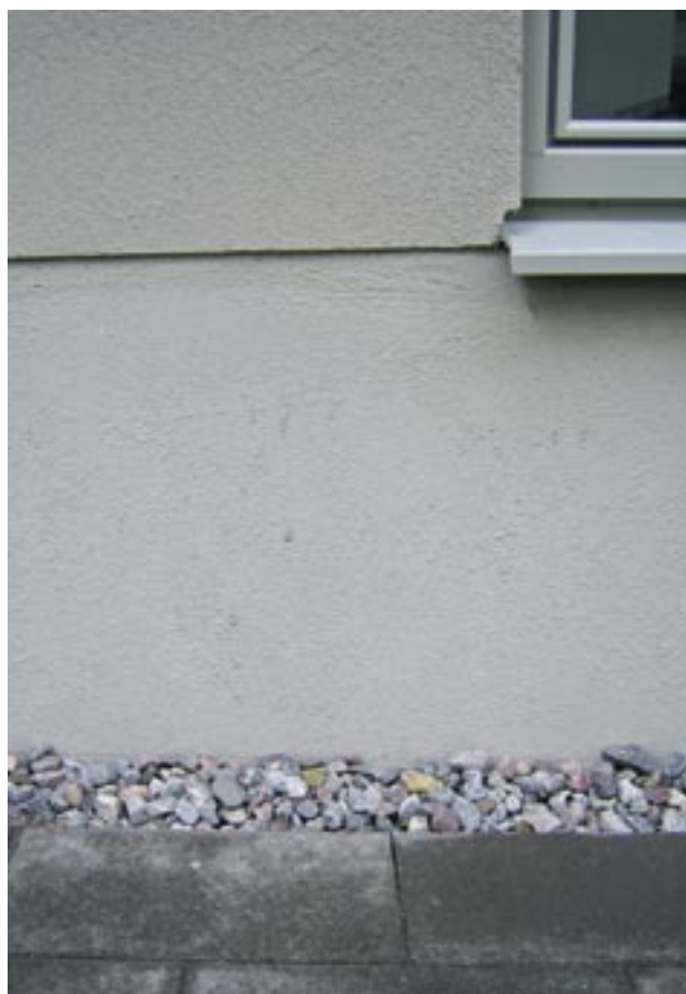
Gode sokkelløsninger med spesialpuss og god drenering forhindrer fuktopptrekk fra grunnen
