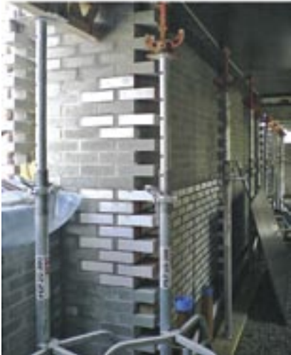
Nopsa betongstein i murverk med hvit, glassert tegl v/ lysarmatur og sanitærutstyr. Grå betong i støpte vegger, gulv og tak.
