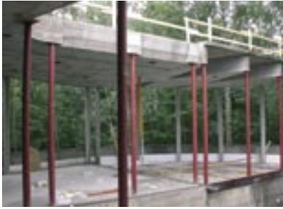
I terrassetakene er dekket lagt vekselvis i over- og underkant av dragere. Stålsøylene fungerer som spindler for dreibare utstillingspaneler.
