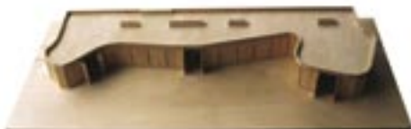
Konkurranseutkastets utstillingsprinsipp: Dreibare paneler langs glassfasaden muliggjør en rekke forskjellige rom- og utstillingsformer, og kan endre publikumsarealet fra et helt lukket til et åpent rom
