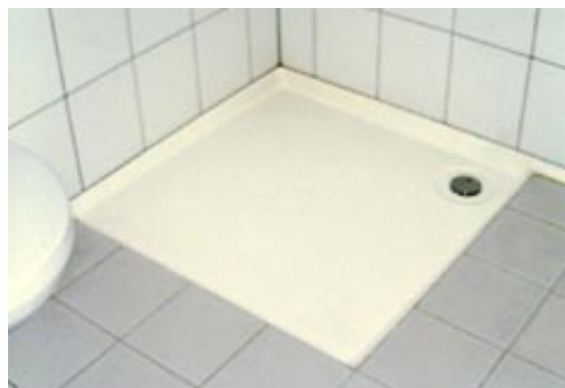
Figur 9: Eksempel på prefabrikkert dusjgrube. Oppkanten er avrundet, slik at den ikke blir en skarp snublekant.
