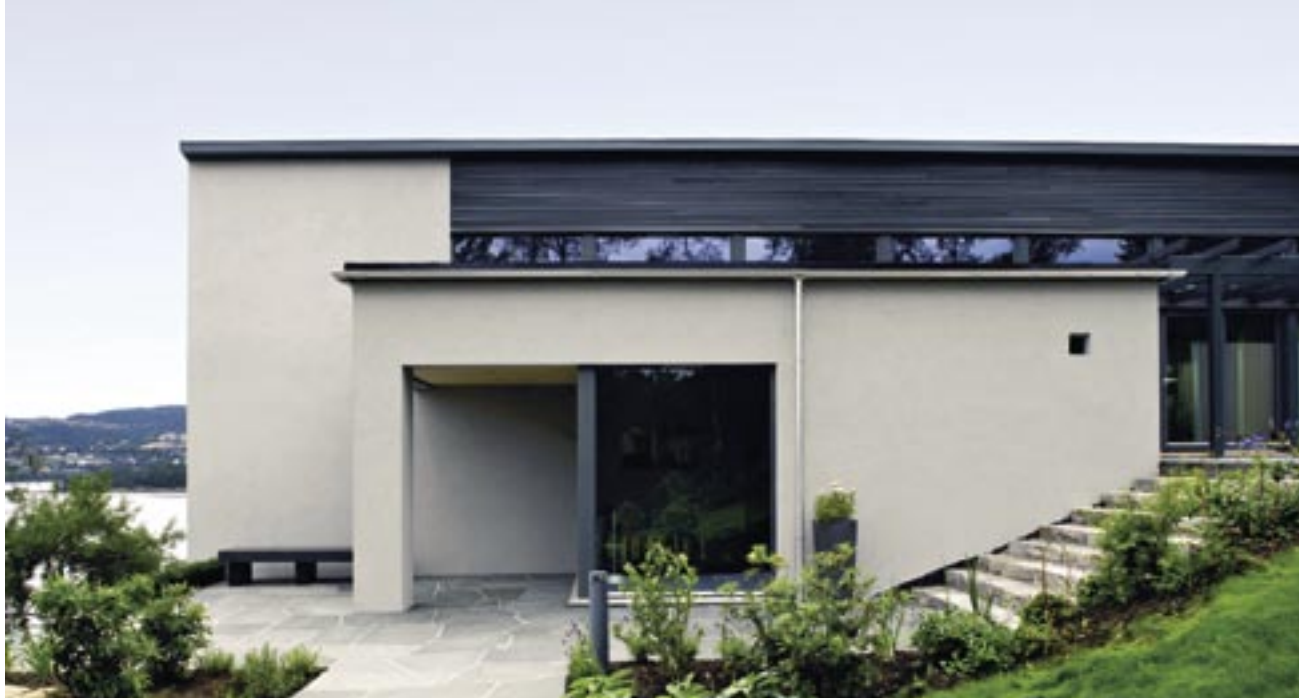
Pusset lettklinkermurverk malt med silikatmaling. Enebolig i Bergen, ark.: Thor Helge Valen, murmester Geir Kalland. Foto: Elmer Laahne. Utlånt fra BMC AS.
