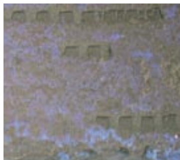
Plasttilsetninger kan redispersere fra lim og bli synlig som en seig væske når flisen fjernes
