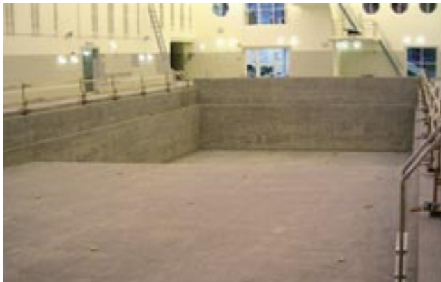
Alle fliser måtte fjernes, og underlaget ble sandblåst og sparklet før nye fliser ble limt med epoksy
