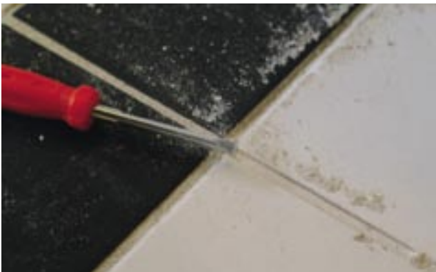
Går fugen i oppløsning etter kort tid, tåler den ikke det vannet den utsettes for
