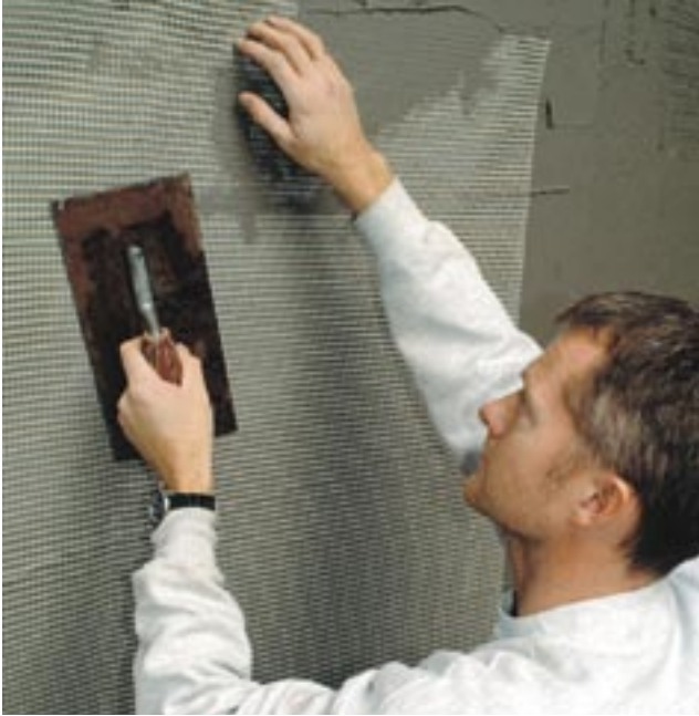
Figur 2: Innbaking av alkaliresistent glassfibernet i påstrykningsmembran
