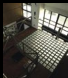
Glassbyggestein brukes i trapperom. Mot trafikkerte gater bør det utvendig fuges med tette og vannavvisende fugemasser. Armeringen i slike konstruksjoner må være korrosjonsbestandig.
