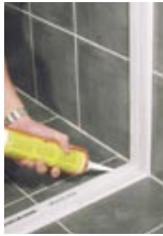
Liming i profiler gir fleksible, raske og sterke løsninger. Profilene settes nøyaktig ut i vinkel og festes. Steinene limes til disse med konstruksjonslim. Bilder fra Proffer AS.
