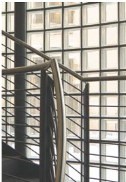
Glassbyggestein brukes i trapperom. Mot trafikkerte gater bør det utvendig fuges med tette og vannavvisende fugemasser. Armeringen i slike konstruksjoner må være korrosjonsbestandig.
