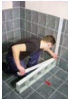
Liming i profiler gir fleksible, raske og sterke løsninger. Profilene settes nøyaktig ut i vinkel og festes. Steinene limes til disse med konstruksjonslim. Bilder fra Proffer AS.
