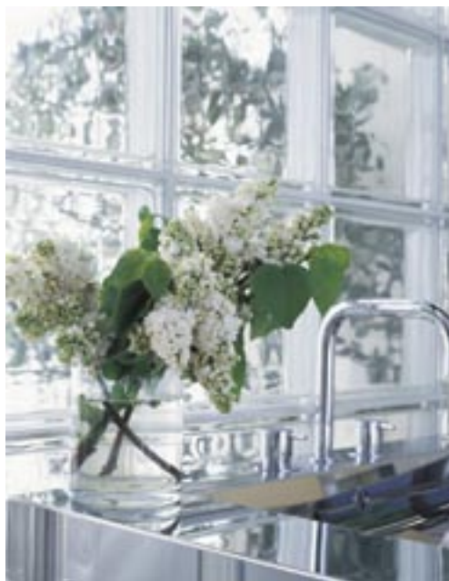
Spesielle lyseffekter oppnås med bruk av glassbyggestein i yttervegg
