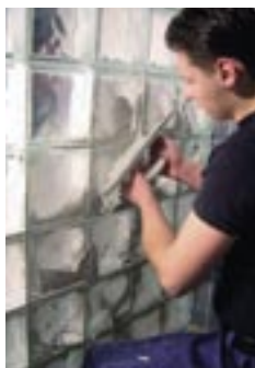
Når limet er herdet kan veggens fuger med fugemasse i ønsket farge.
