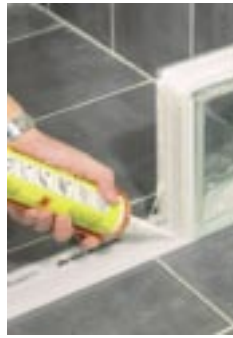
Liming i profiler gir fleksible, raske og sterke løsninger. Profilene settes nøyaktig ut i vinkel og festes. Steinene limes til disse med konstruksjonslim. Bilder fra Proffer AS.
