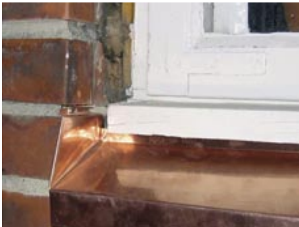
Sålbenkbeslag på stedet
