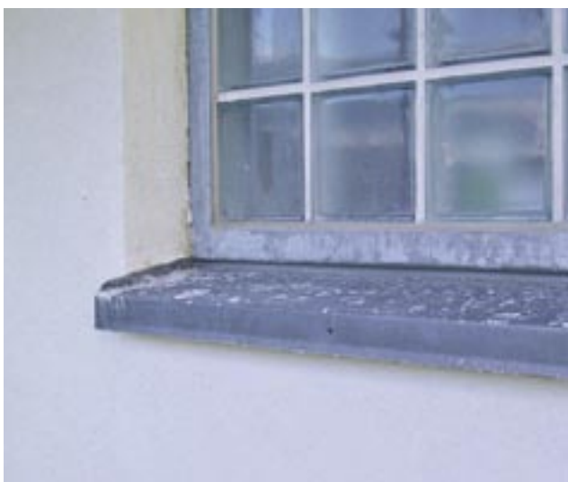
Innpussing av beslag uten rom for bevegelse. Kamspiker i front?
