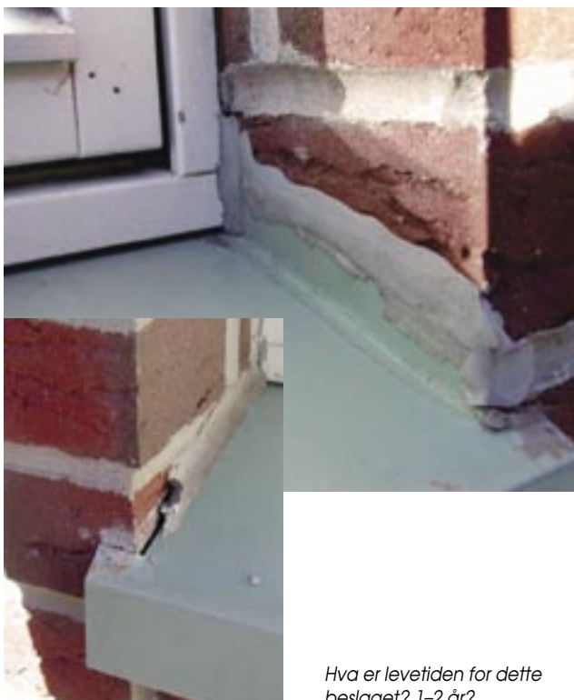
Innpussing av beslag uten rom for bevegelse. Kamspiker i front?
