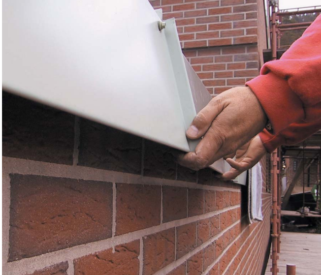
Manglende forankring
