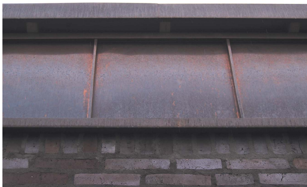
Korrekt utført gesimsbeslag
