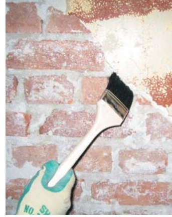
Skjøter mot gammel puss skjæres rette og forsterkes med kaliumvannglass.
