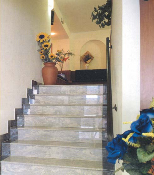
Bilde 1: Eksempel på lukket betongtrapp der overgang til vegg er markert med farger
