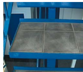
Bilde 2: Ståltrapp med limt flis på betong
