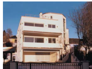
Tuengveien 3, Oslo. Fiberpuss med Maxit silikatpuss som slutt- behandling.
