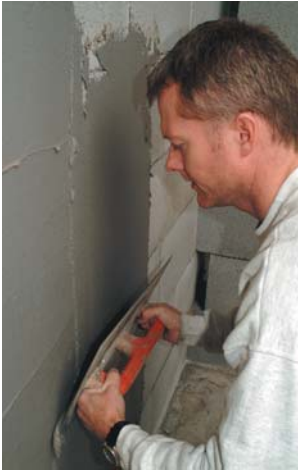
1: Mørtelen påføres med stål Brett eller sprøytes på murverket
