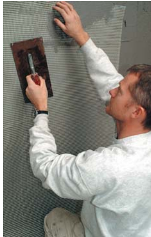
2: Sjikttykkelsene er avhengig av valgt sluttbehandling: Til maling: Sjikttykkelse 6+2 mm. Til slutt puss: 4+4 mm. Fibernettet bakes inn i pussen til nettet ikke er synlig som annet enn en forsiktig struktur i mørtelen
