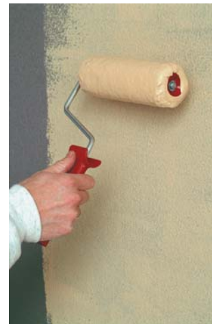
6-7-8: Som sluttbehandling på Fiberpussen kan det velges to strøk silikatmaling, Serpo 303, silikatpuss eller spesialmørtel Stenkuss Serpo 462. Velges silikatpuss grunnes flaten først med Maxit silikatmaling før pussen påføres i 1 sjikt, og behandles til ønsket overflate. Silikatpussen kan påføres med Brett, sprøyte eller stenkapparat. Slutt pussene finnes i et standardsortiment på 36 farger, – se fargekart på www.optiroc.no . Optiroc Fiberpuss er testet i NBIs Klima 2000-prosjekt og er, med sine anbefalte sluttbehandlinger, dokumentert slagregntett.
