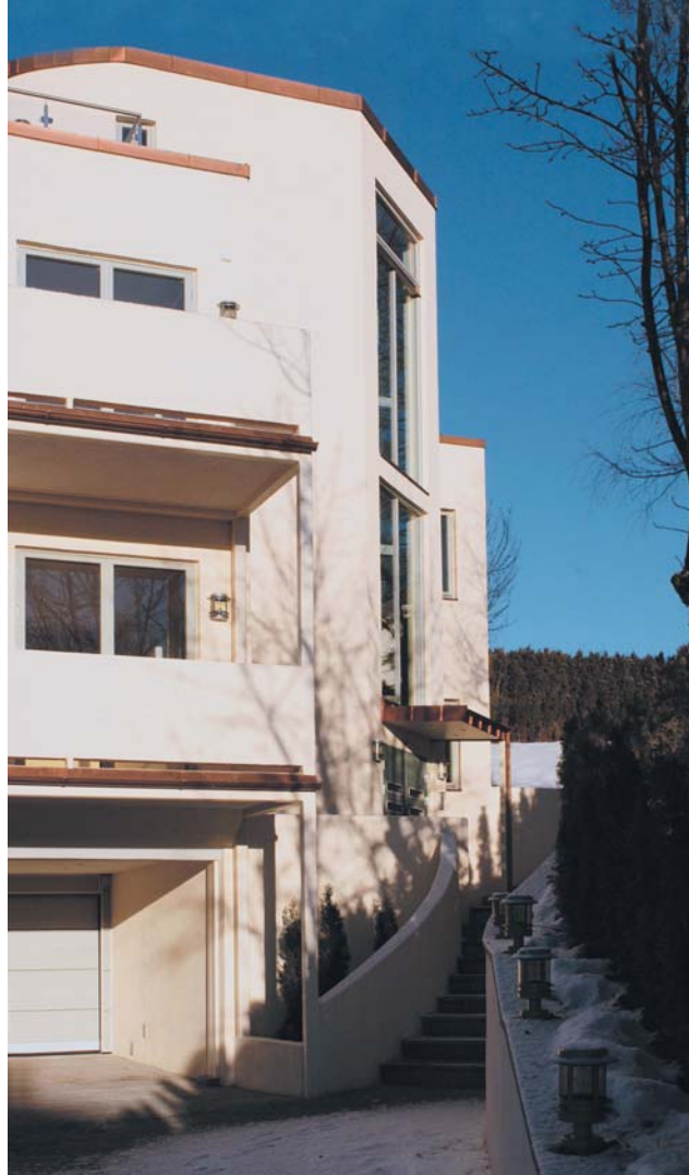
Tuengveien 3, Oslo. Fiberpuss med Maxit silikatpuss som slutt- behandling.
