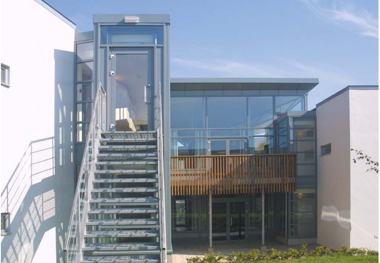
Felles uteplasser mot vest sammen med rømningsstrapp fra korridor
