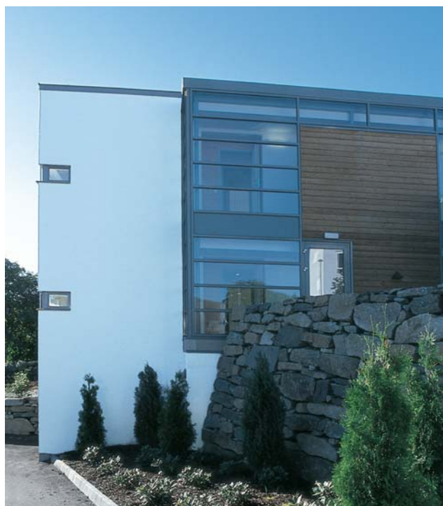
Hvitmalt lecavegg mot sørøst med overganger til trekledning og aluminium
