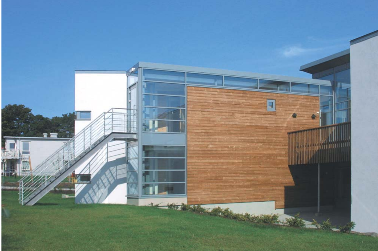
Korridorzone og rømningsstrapp mot vest
