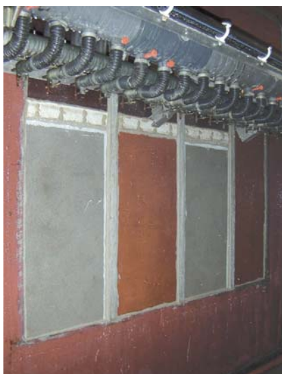
Pussprøver inne i slagregnskapet under prøving. Bildet viser regnpåføring i øvre kant av prøvestykkene.
