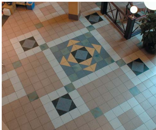
Porcellanato – lavt vannopptak og god målenøyaktighet. Fra Vinterbro senter. Ark.: Aakerøy, Moe & Bow
