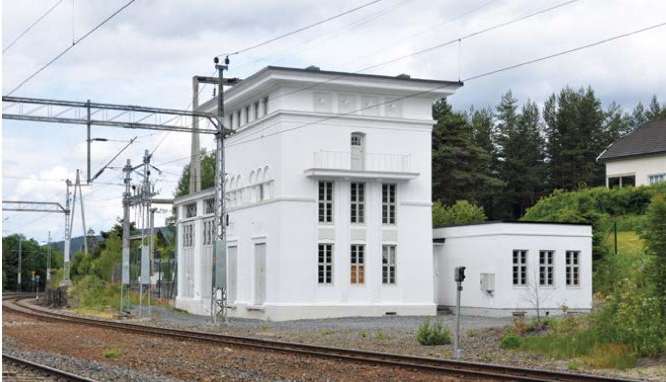
Skollenborg transformatorstasjon. Hovedbygningen ble satt i drift i 1929 og det lavere tilbygget til høyre i bildet i 1956. Ark. Gudmund Hoel, NSBs arkitektkontor Foto: Henning Weyergang-Nielsen, NVE
