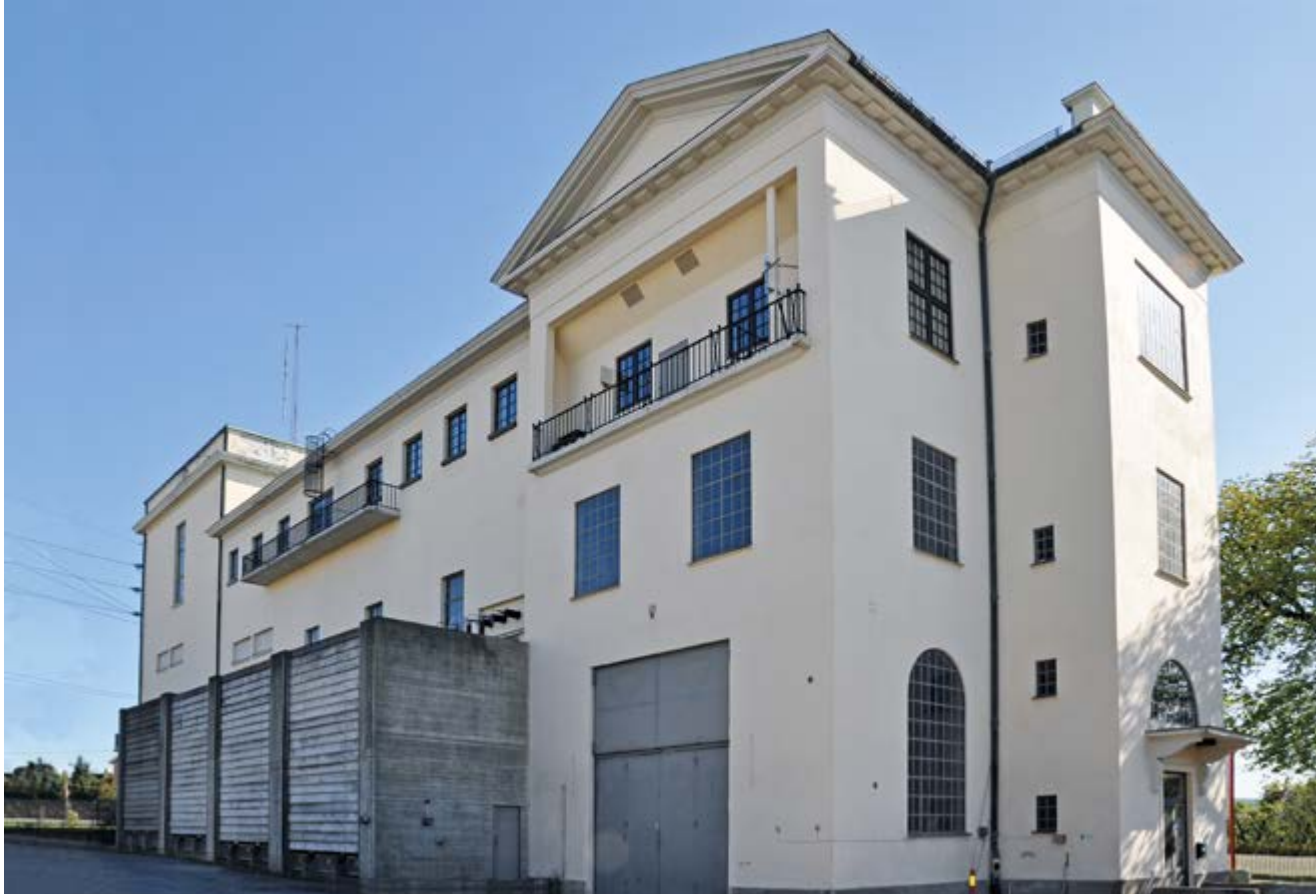
Tonsen transformatorstasjon. Ved gjenoppbyggingen i 1933 ble hovedtransformatorene plassert utendørs (ark. Jørgen H. Berner). Foto: Sissel Riibe. NVE
