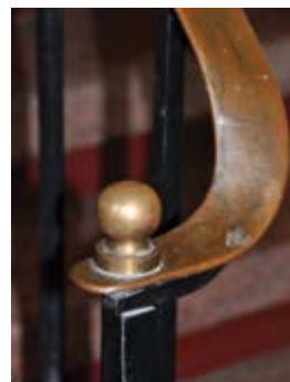
Detalj av trappegelender i Noreveien 24 Foto: Sissel Riibe, NVE
