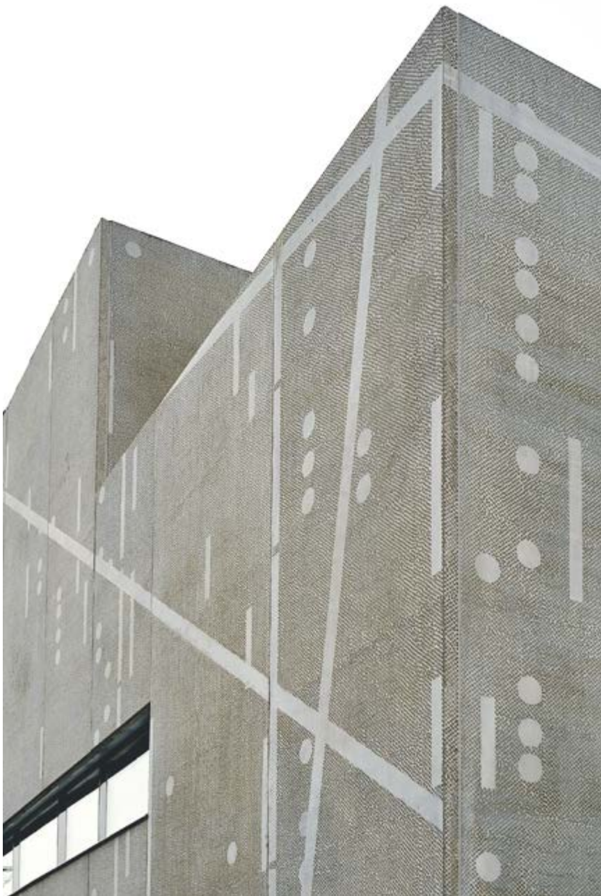
Grafisk betong lages ved at mønsteret trykkes med retarder på papir som legges i formen. Mønsteres kan dermed spyles frem ved avforming
