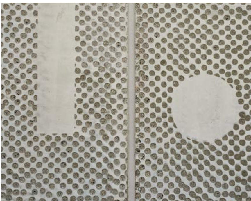
Grafisk betong lages ved at mønsteret trykkes med retarder på papir som legges i formen. Mønsteres kan dermed spyles frem ved avforming
