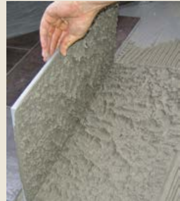
Figur 6: 'Slakteprøven' benyttes for å påse at det er full kontakt mellom lim og flis
