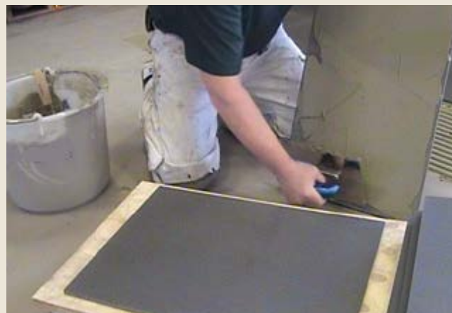
Figur 11: Full limdekning krever riktig materialvalg og omhyggelig utførelse
