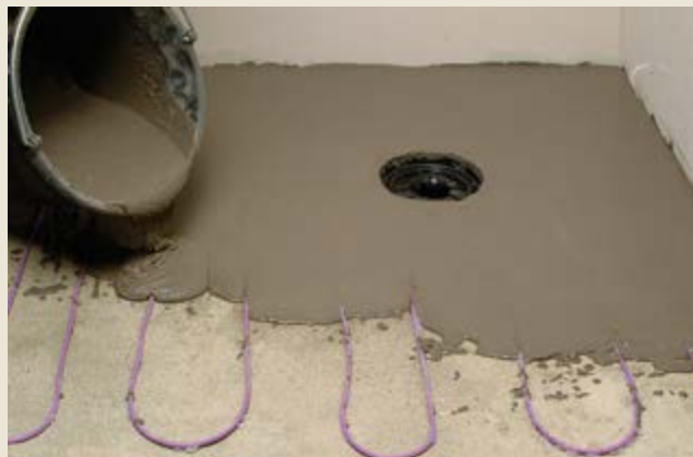
Figur 15: I sammensatte konstruksjoner f.eks. et våtromsgulv med påstøp, innstøpingsmasser, membran og flislag beskrives delmaterialene under forskjellige delen selv om arbeidene gjerne utføres av en og samme håndverker
