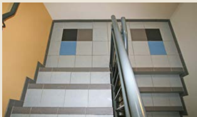
Figur 17: Trappese med kontrastmerking beskrives i egen post (Siffer 37 i matrise NH:1 – Bygningsdel)
