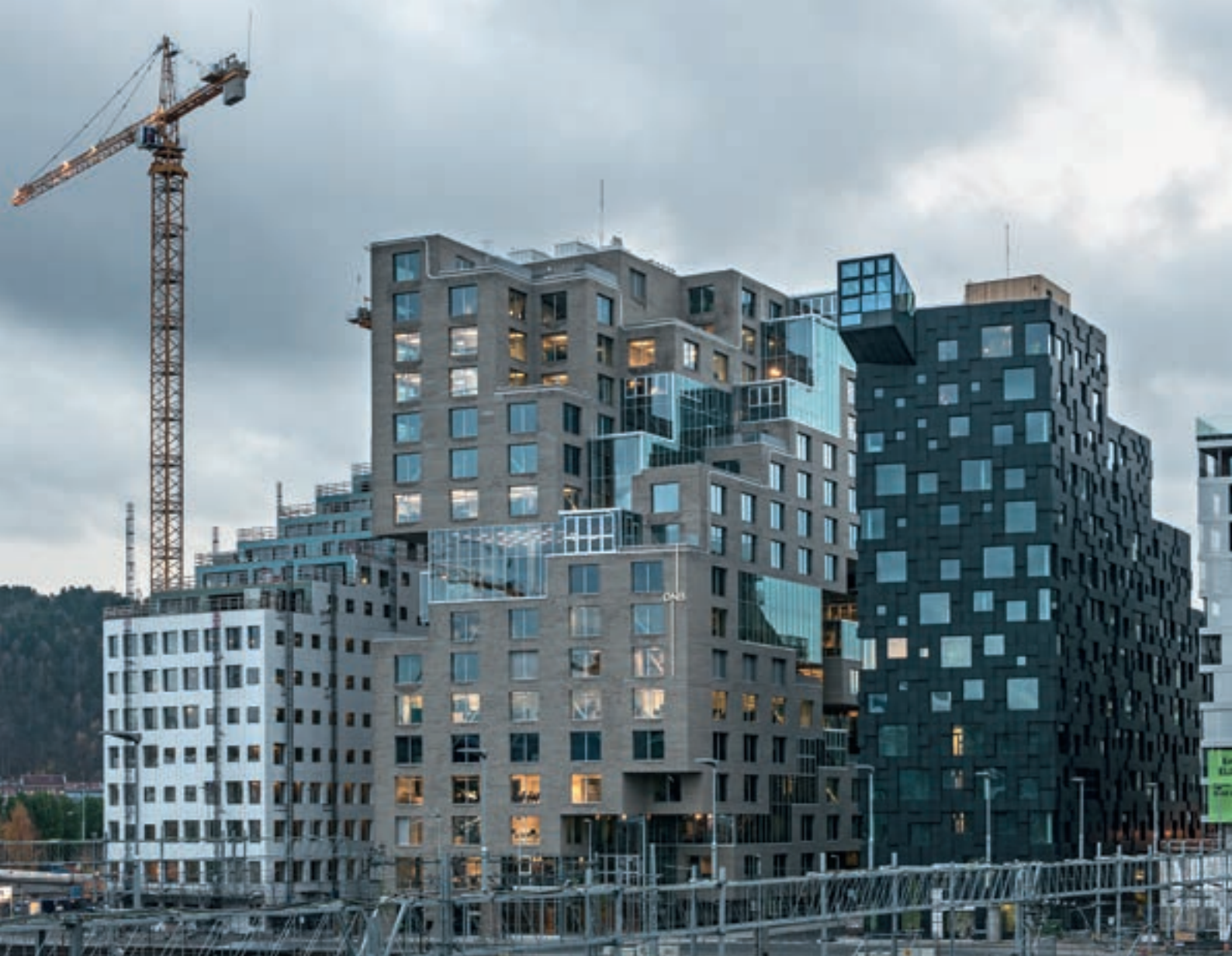
Sett fra nord-vest. Ifølge reguleringen skulle hvert bygg avvike fra nabobygg i fasademateriale og farge. DNB-komplekset fremstår derfor som tre helt ulike bygninger
