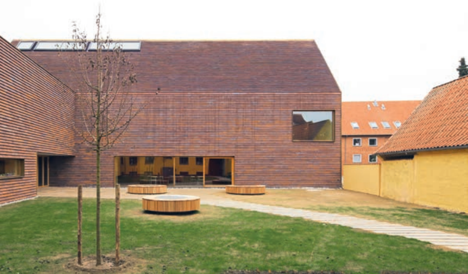
Tilbygget består av en ny, lang bygningskropp, et mindre mellombygg og et underjordisk utstillingsareal. Rehabiliteringen av den gamle museumsbygningen fra 1832 foregikk parallelt
