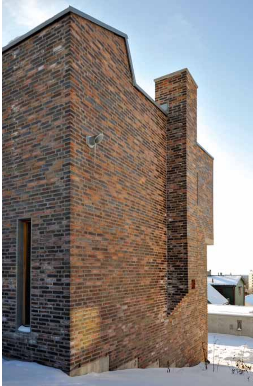
Sett fra nord. Teglsteinen har store variasjoner både i farge og dimensjoner, noe som gir store fugebredder og en grov struktur på veggflaten
