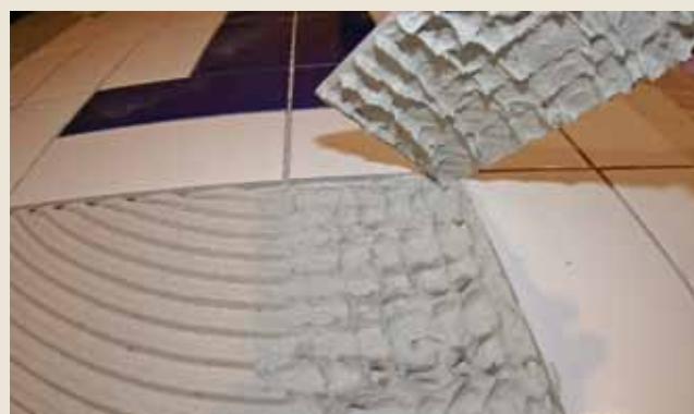
Unngå hulrom bak flisene, 100% limdekking/baksmøring!
