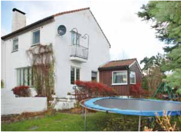
Halvpart tomannsbolig før tilbygg
