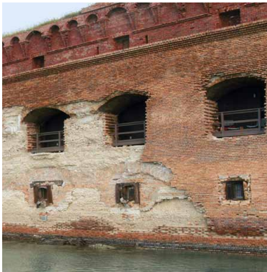
Armeringskorrosjon i kombinasjon med forbigående orkaner har gjort stor skade på de ytre murene i årenes løp. Bare i 2005 ble Garden Key rammet av hele tre orkaner.
