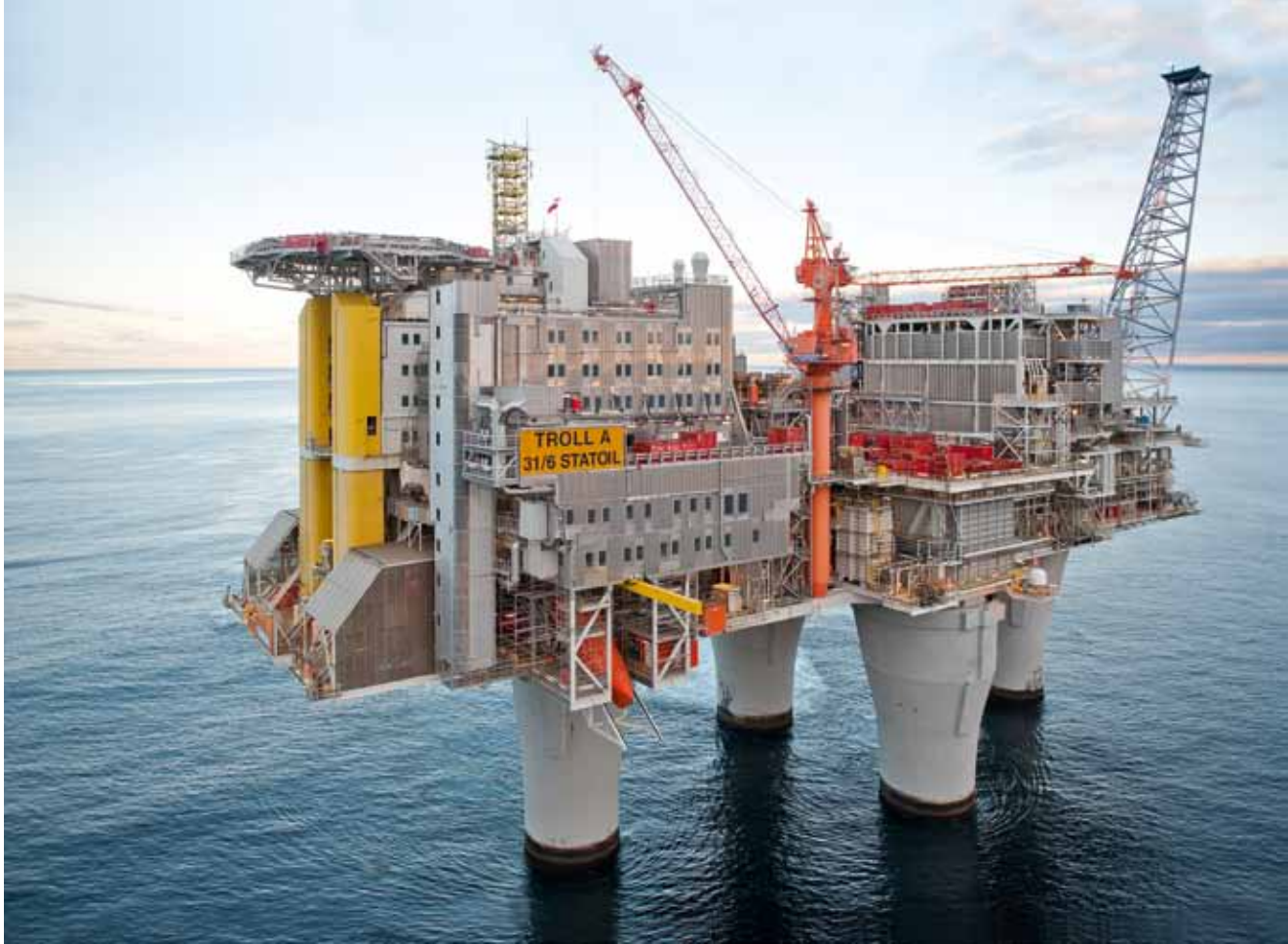
Den største av alle Condeep-plattformene er Troll A. Den står på 300 meters dyp og rager totalt over 470 meter. Hadde Troll A stått på landjorda hadde den vært verdens fjerde høyeste bygning, bare slått av tre skyskrapere bygget etter år 2000 Foto: Øyvind Hagen/Statoil
