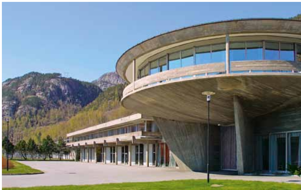
Nesflaten. Arkitekt: Geir Grung.
