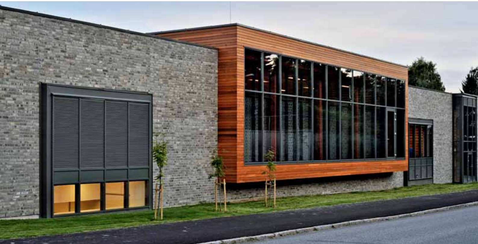
Fasade mot Dalsveien. Gymsalen har en åpen og fremskutt sedertresfasade med mye glass.
