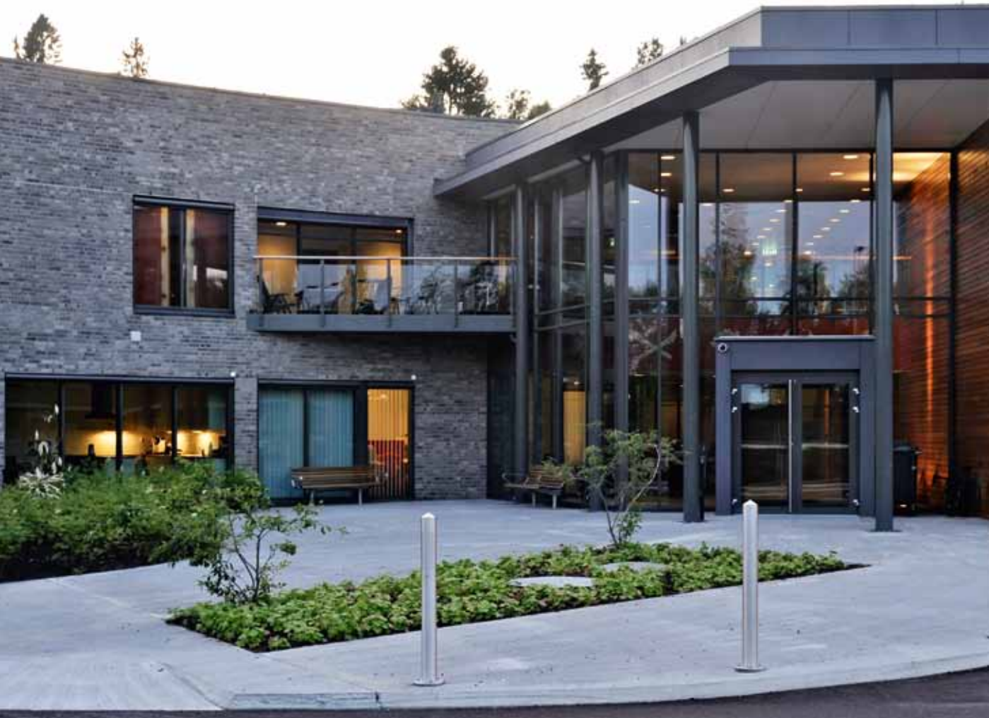
Det mellomliggende inngangspartiet i glass henvender seg mot gårdsplassen og atkomstveien
