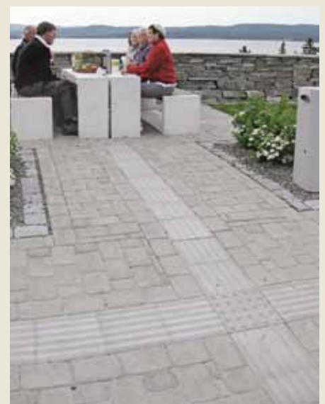
Figur 7: I Norge arbeides det med å lage gode regler for ledelinjer både innendørs og i utearealer. Farger og strukturer må gjennomtenkes. Bildet til høyre viser en god taktile overflate, men hva med kontrasten?
