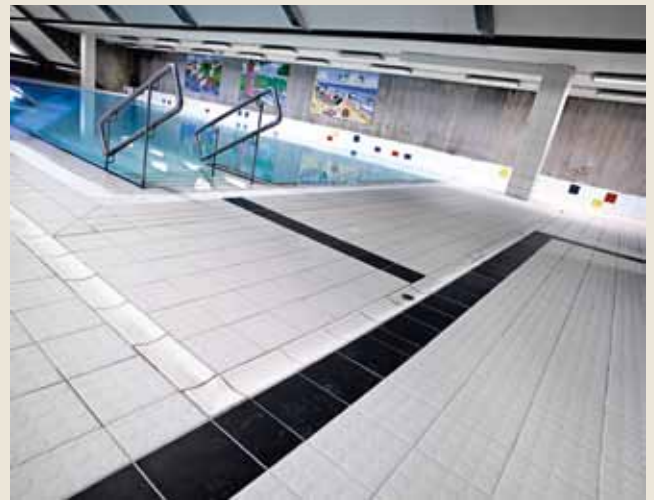
Figur 5 a og b: Ledelinjen på garderobegulvet til venstre er best synlig for en svaksynt. Men med så stor kontrast som på bassenggulvet til høyre er det heller ikke vanskelig å innfri kravene i TEK10 med en lys hovedfarge og mørk ledelinje
